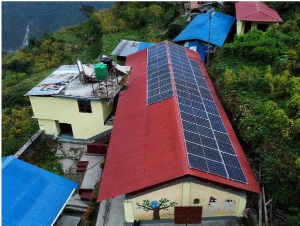
Abbildung 14: Fertige PV-Anlage auf dem Dach, 21.3 kWp
